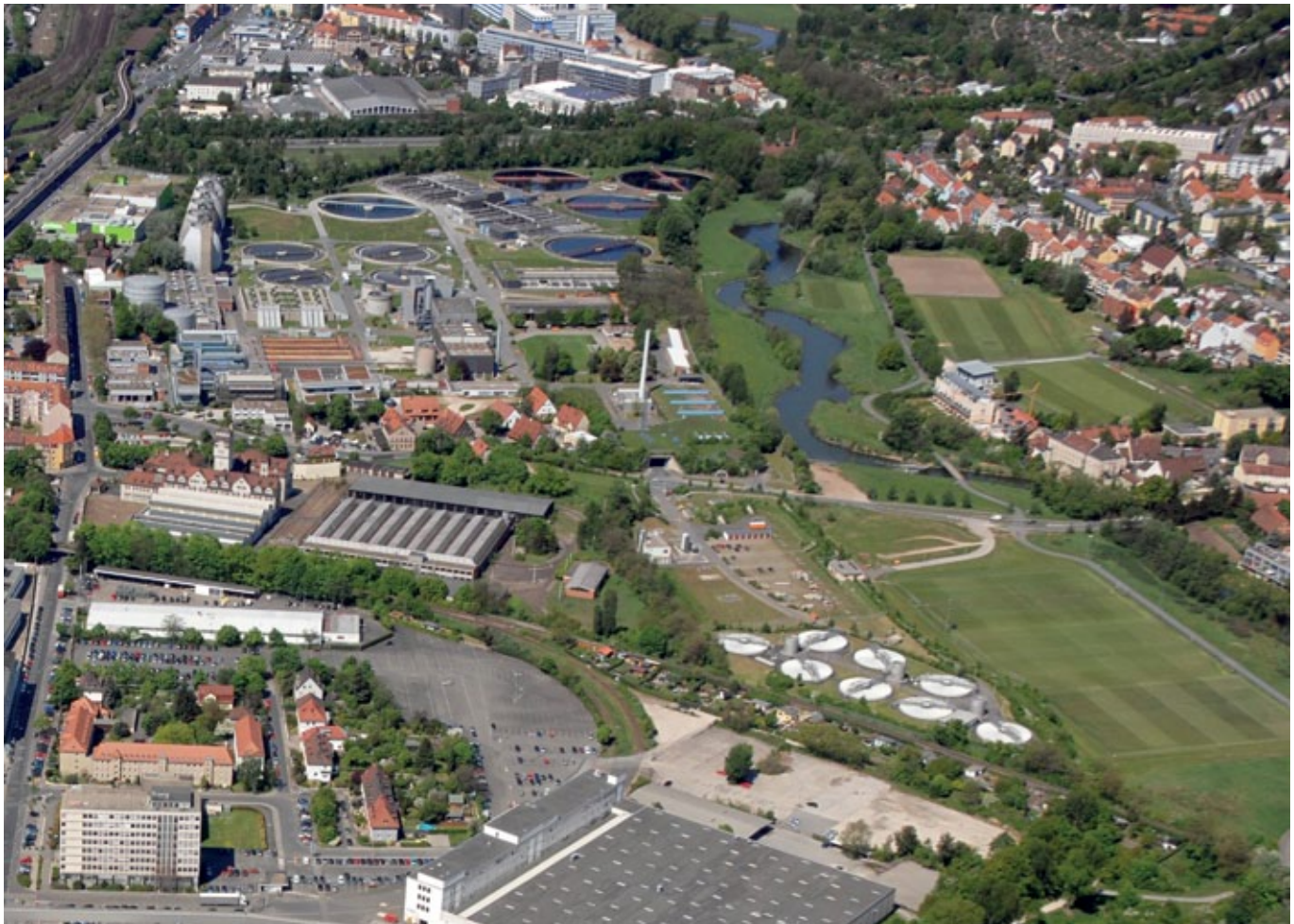
Klärwerk 1 in Doos.
